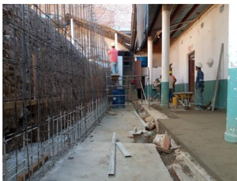
Foto 1. Construcción muro contención
