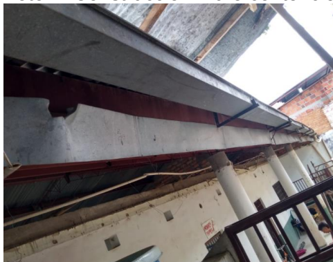
Foto 3. Arreglo de Cubierta
