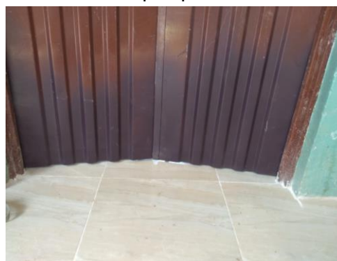
Foto 4. Pintura carpintería Metálica
